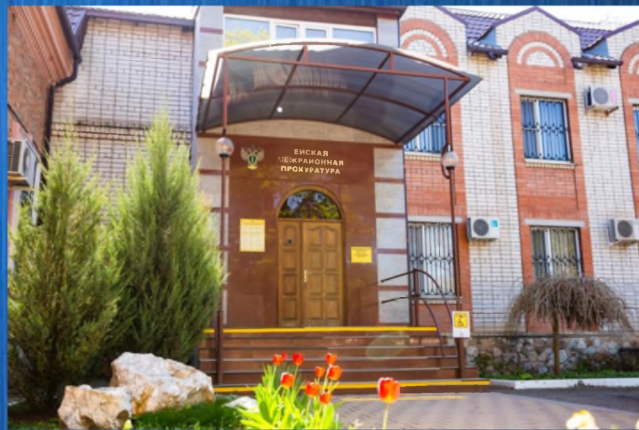
Новое здание Ейской межрайонной прокуратуры, г. Ейск, май 2020 г.
